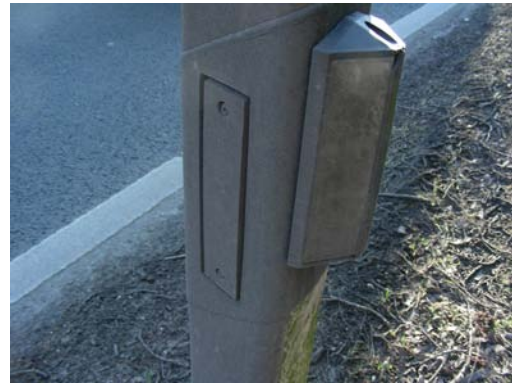
Abb. 6: Ein stark verschmutzter Winkelreflektor an einer Landstraße, so ist er unwirksam.
